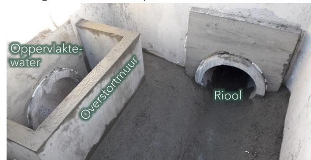
Nieuwe overstortput binnenzijde
