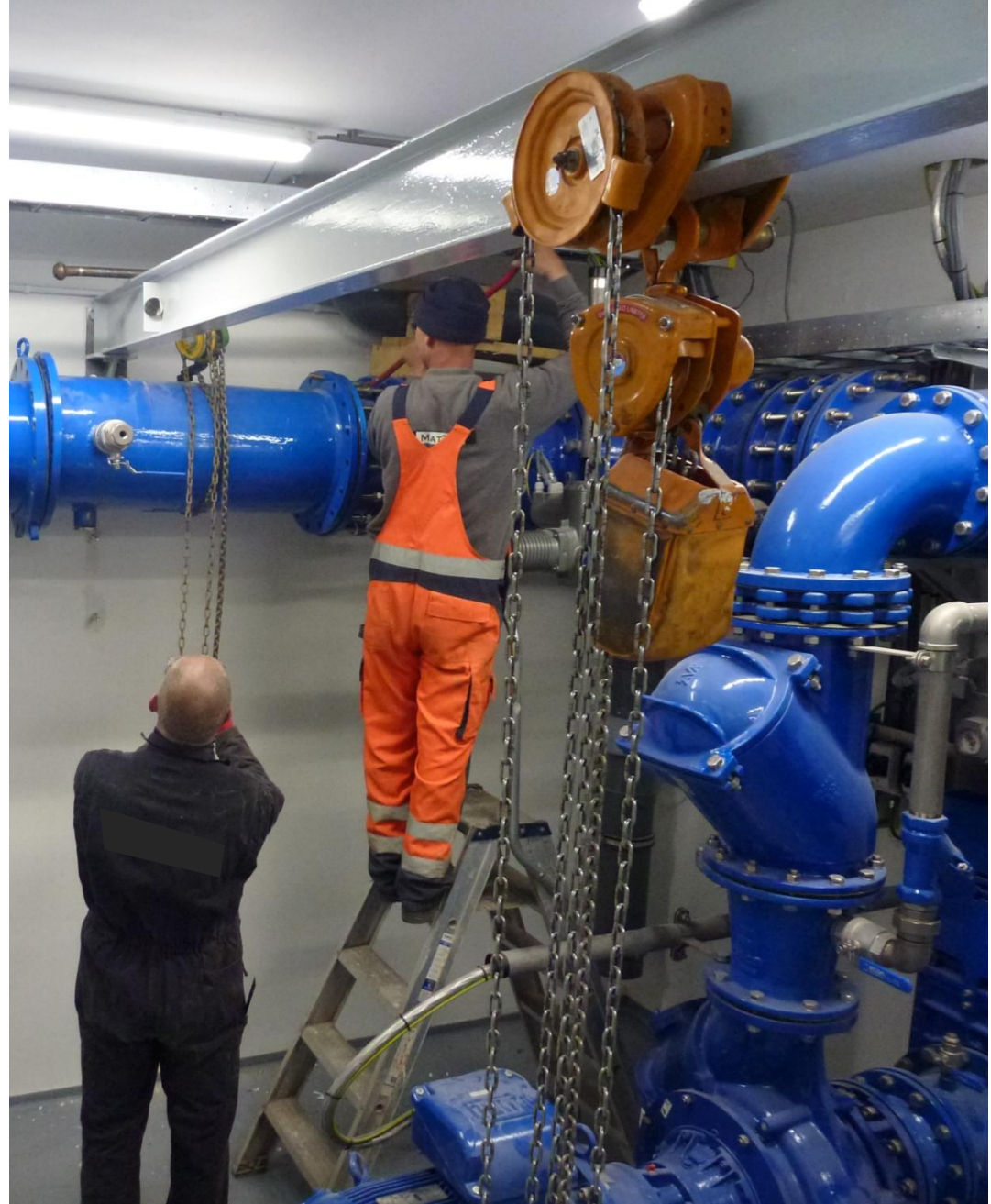
Renovatie gemaal Kerkstraat
