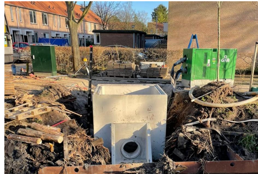
Aanleg nieuwe overstortput
