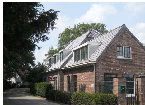
De richting van de hoofd- en bijgebouwen is evenwijdig aan de dijk
