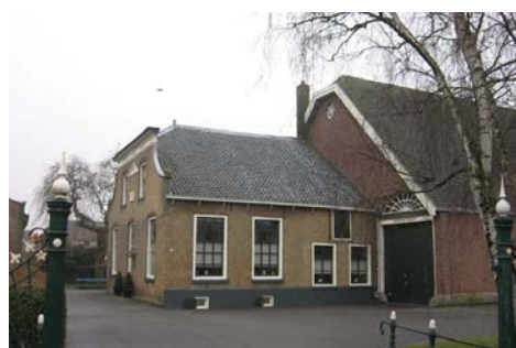
De bebouwing heeft één bouwlaag met een kap (type zadeldak)
