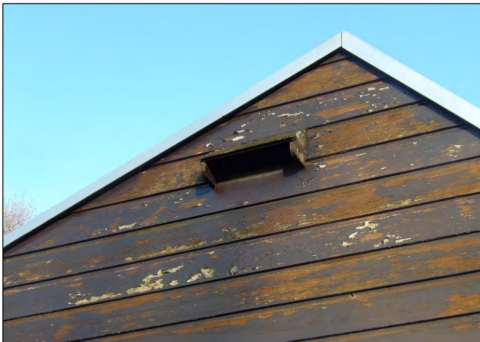
Figuur 11: De stal heeft een geschikte opening, waardoor vleermuizen toegang hebben tot de stal. Tussen de aluminium daklijst en de wanden is onvoldoende ruimte voor vleermuizen om tussen te kruipen.
