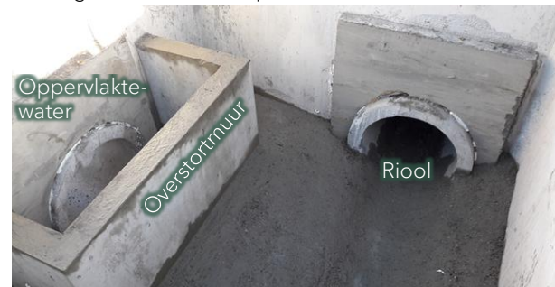
Nieuwe overstortput binnenzijde
