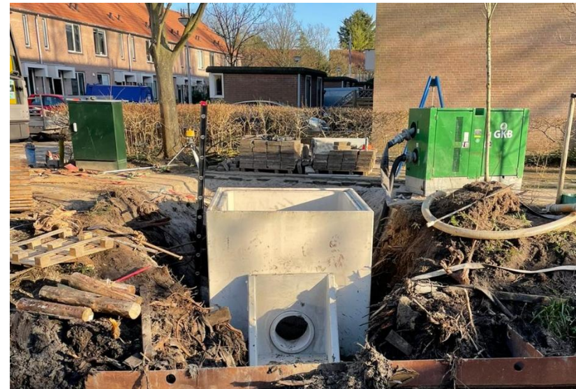
Aanleg nieuwe overstortput
