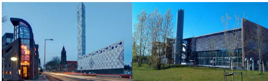
Voorbeeld centrale warmtepomp in Enschede
