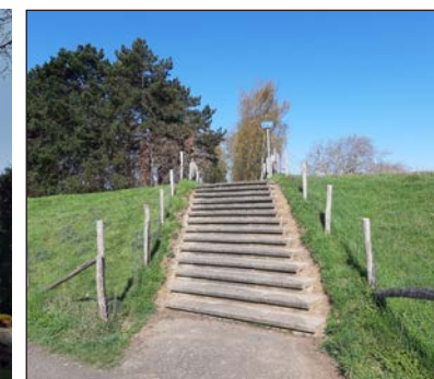
beelden van de bestaande situatie
