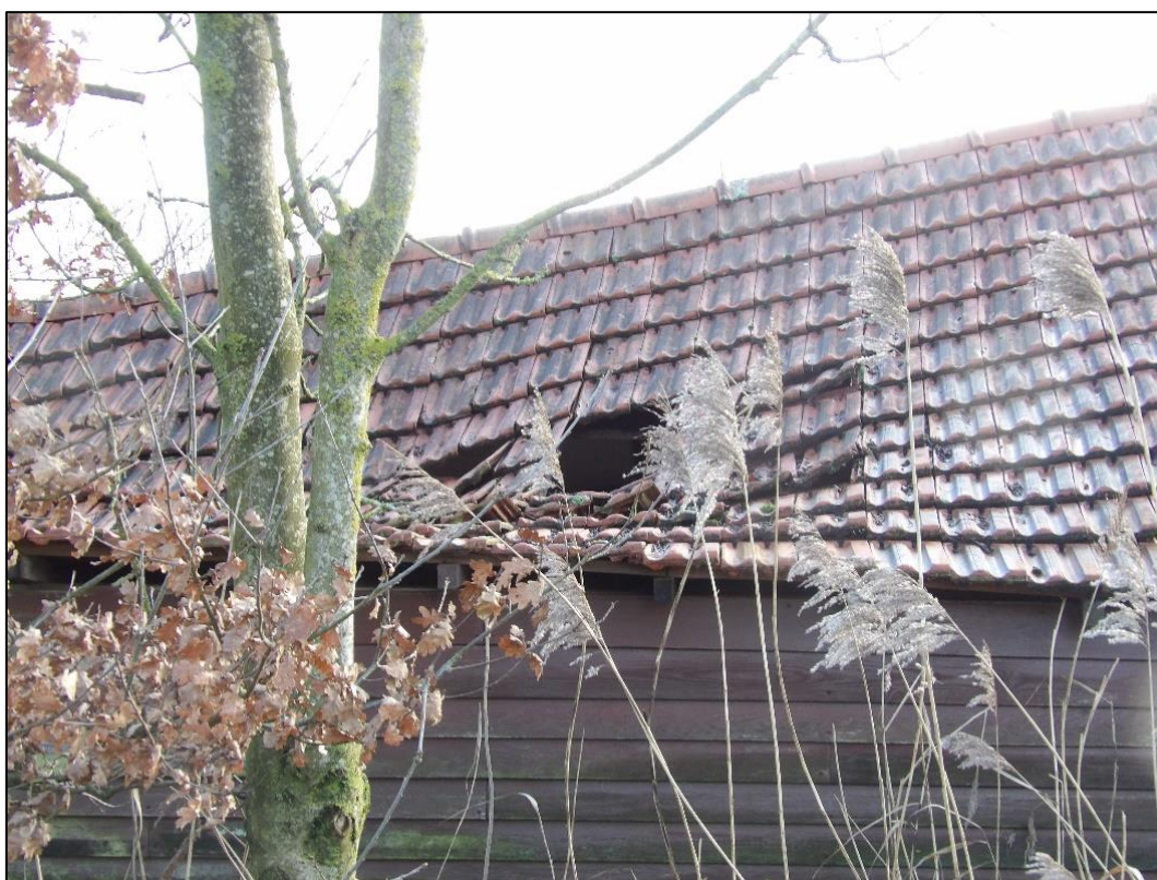
Figuur 8: Op het dak van de schuur, gelegen ten zuiden van het perceel, zijn ruimtes tussen dakpannen aanwezig, waar huismussen en gierzwaluwen een verblijfplaats onder de dakpannen kunnen hebben.
