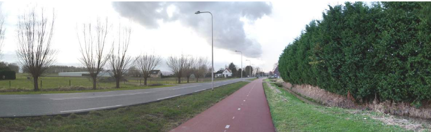
Huidige situatie Albrandswaardseweg
