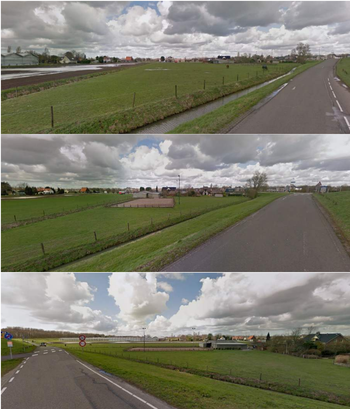
Overzichtsfoto's bestaande situatie (bron: maps.google.com)
