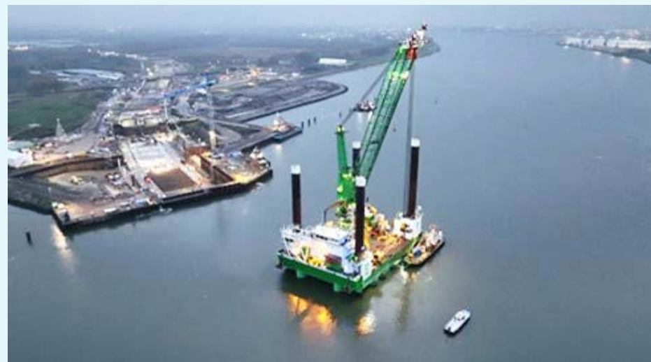
Aanleg tunnel in de Blankenburgverbinding. Foto: Rijkswaterstaat
