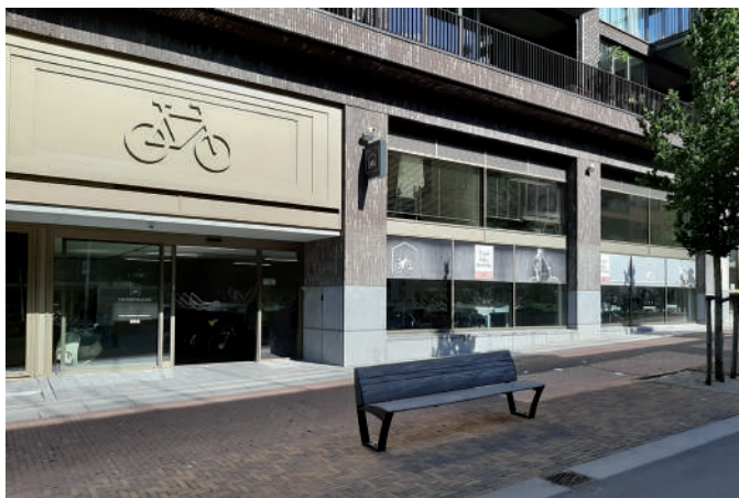
Referentie fietsenstalling in plint: Leidsche Rijn
