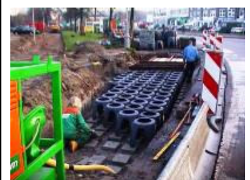
plaatsing watershells, welke met bomengrond worden gevuld
