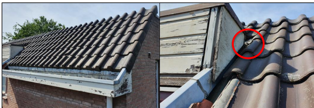
Figuur 6 Visuele ondersteuning van het nauw aansluiten van de dakpannen op de goot (L) en rood omcirkeld dat er overige plaatsen zijn waar toegang tot de dakruimte verleend wordt (R).
