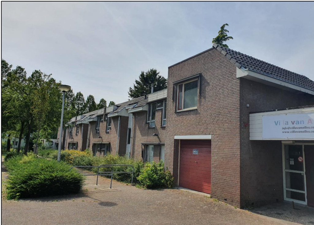
Figuur 1 De planlocatie is gelegen aan de Dorpsdijk 40 en 40a te Rhooen en bestaat uit twee gebouwen opgetrokken uit gemetselde muren met deels plat dak en deels hellend dak.
