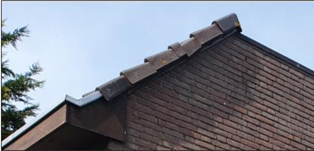
Figuur 7 Visuele ondersteuning van het nauw aansluiten van de kantpannen op de aluminium daklijst.
