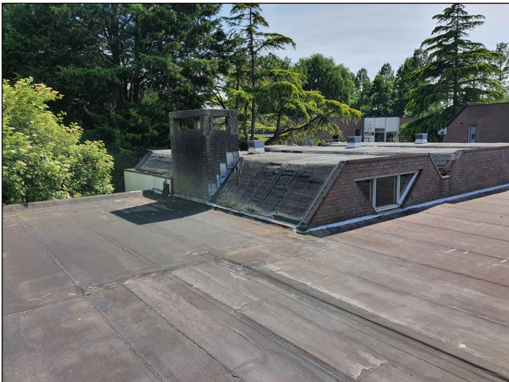
Figuur 2 De bebouwing heeft hoofdzakelijk plat bitumen daken.
