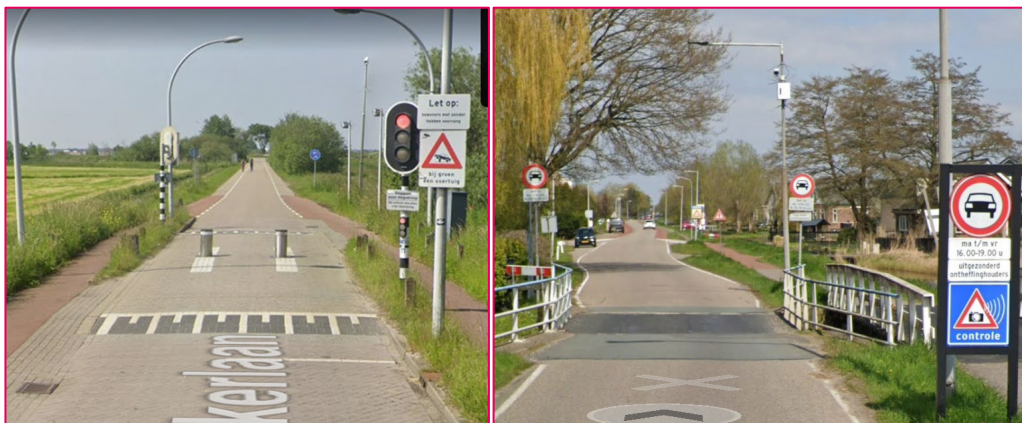
Figuur 5.12: Voorbeeld van een fysieke afsluiting (een doseerpunt in het buitengebied van Zwolle) en een camera-afsluiting tijdens de spits (met ontheffingen, Den IJp - Landsmeer) 15
