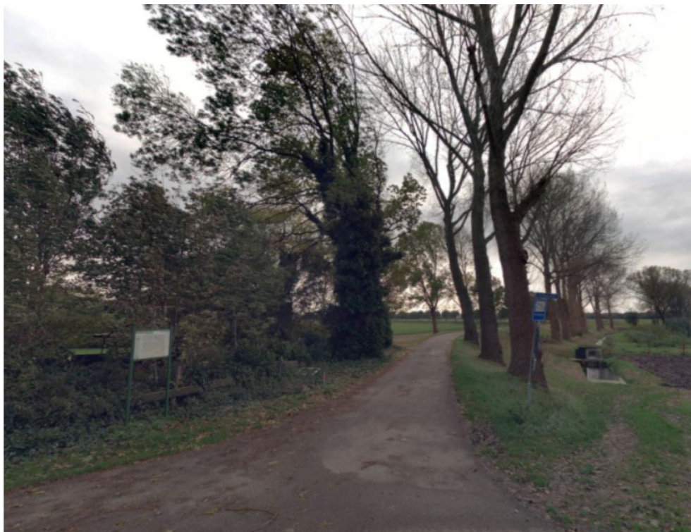
Figuur 5.15: Schenkeldijk aan de noordzijde bij de aansluiting met de Essendijk
