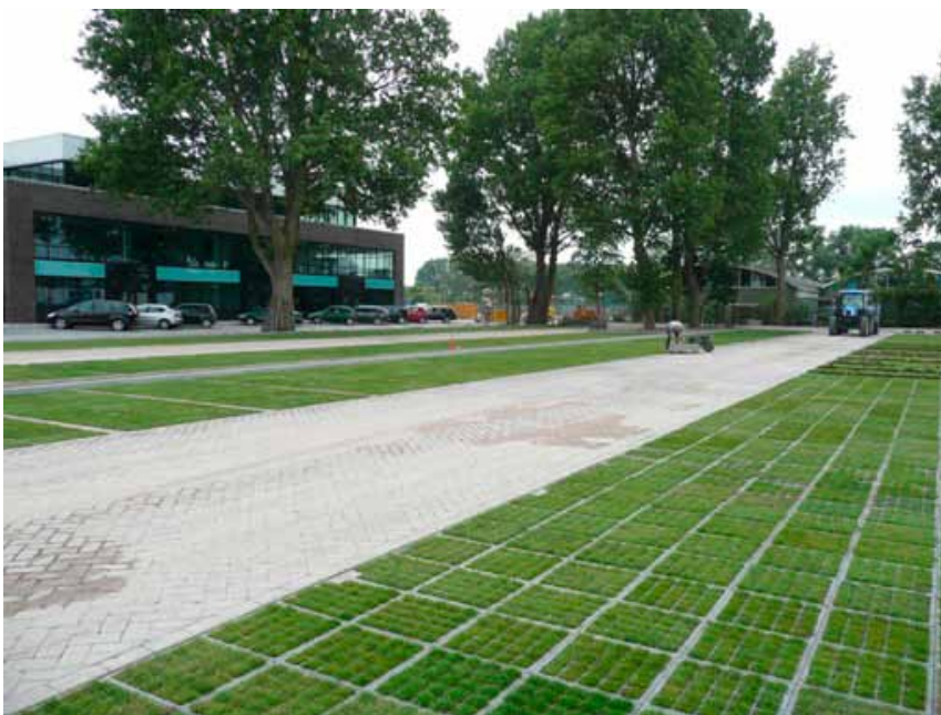
Waar mogelijk wordt waterdoorlatende bestrating toegepast (ten behoeve van infiltratie)
