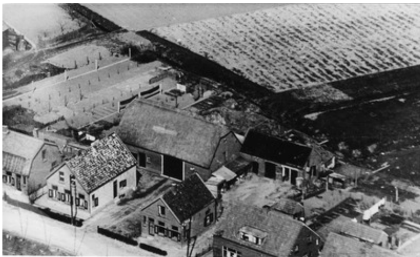
Afb. 3. De Dorpsdijk in Rhoon rond 1950. Links is het huis Dorpsdijk 15 (in het plangebied gelegen) te zien; rechts daarvan het huis Dorpsdijk 17 met daarachter een twee schuren/stallen. Huis en schuren/stallen zijn restanten van boerderij Molenzicht. Het terrein achter Dorpsdijk 15 en links van de grote schuur/stal is het plangebied. Bron: Website Stichting Oudheidkamer Rhoon en Poortugaal.
