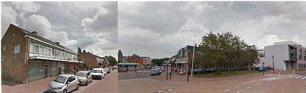
Situatie bestaand (bron: google streetview)
