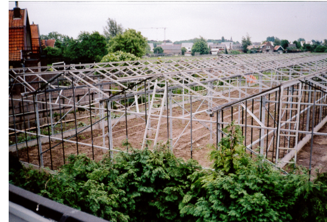
Afbeelding 3: De kas in aanbouw
