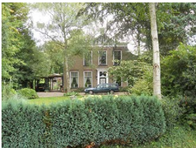
Monumentale boerderij aan de Dorpsdijk
