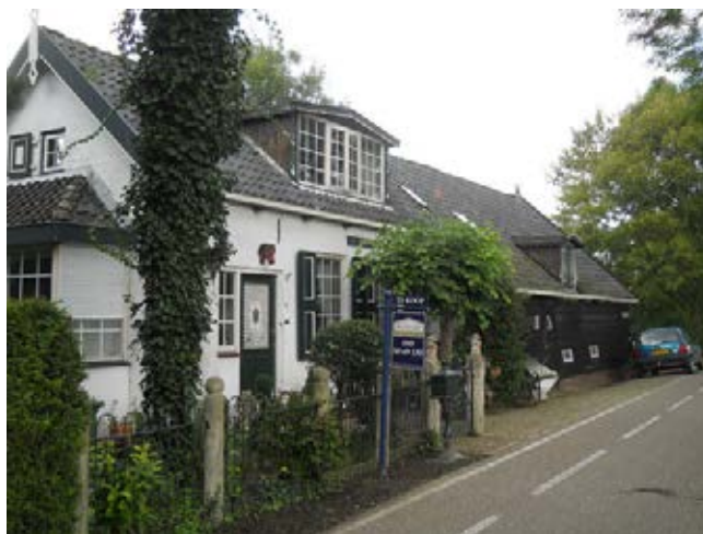
Dijkboerderij aan de Slot Valkensteinsedijk
