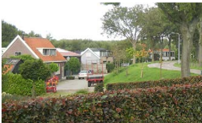
Dijkwoningen op/onderaan de dijk
