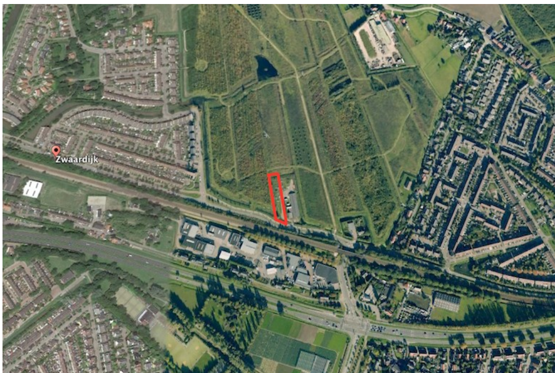
Fig. 1.1 Luchtfoto Zwaardijk 17 (met projectlocatie rood omkaderd)
