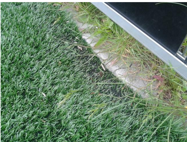
afbeelding 7: zakking / instabiel uiterste achteruitloop
