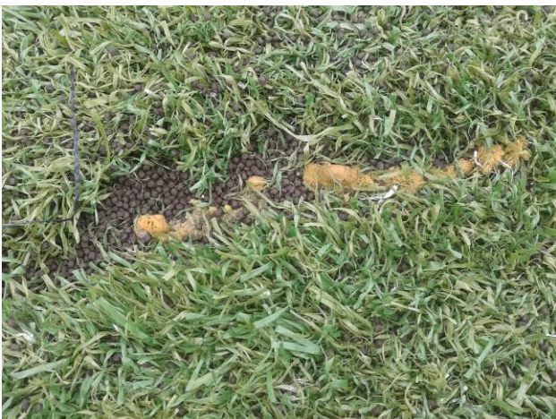
afbeelding 10: (scherpe) lijmresten
