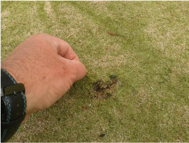
afbeelding 5: losse naad / schade
