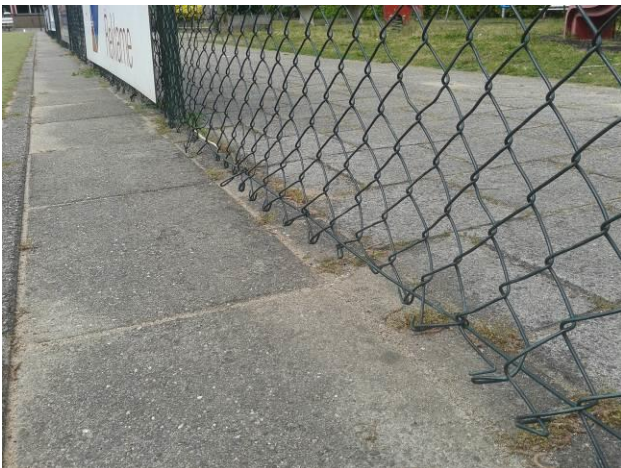
afbeelding 9: scherpe delen gaashekwerk
