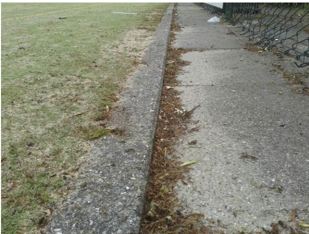
afbeelding 7: drempelvormige overgang band - tegel
