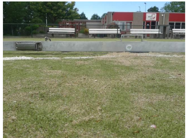
afbeelding 8: drempelvormige korfbalkoker
