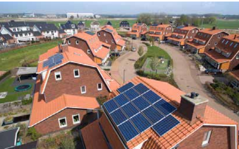
In de proeftuin Hoog-Dalem (Gorinchem) onderzoekt Stedin of energieopslag een optie is om netinvesteringen te beperken.
