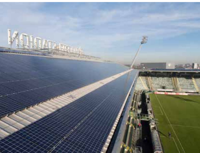
2.900 zonnepanelen op het dak van stadion Kyocera in Den Haag.
