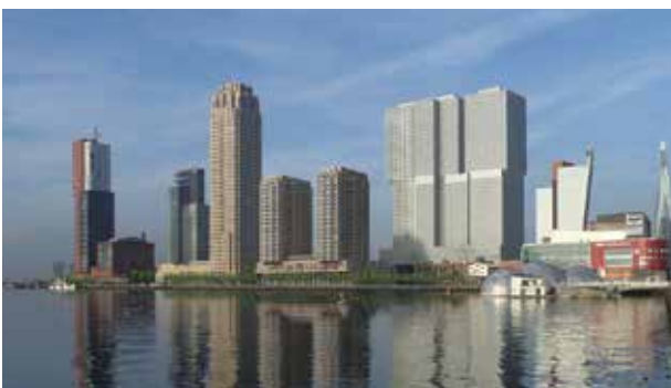
Warmtelevering en koeling met gebruik van Maaswater voor gebouwen op de Rotterdamse Wilhelminapier.
