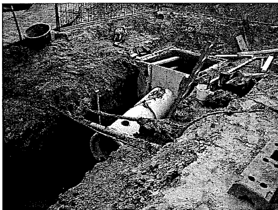
Afbeelding: Hoofdriool in rioolsleuf
