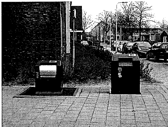
Afbeelding: Ondergrondse vuilcontainers
