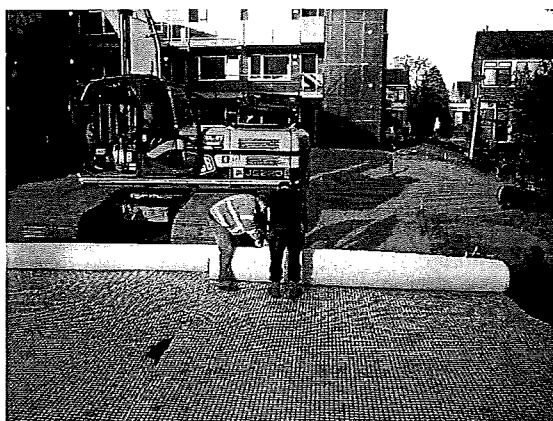
Afbeelding: Aanbrengen geogrid
