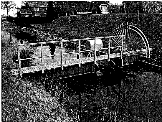
Afbeelding: Geautomatiseerde kantelstuw
