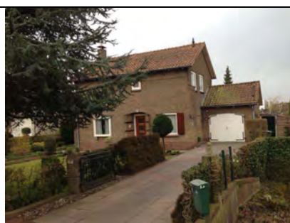
Voorgevel met oprit en aangebouwde garage.
