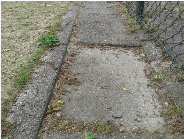
afbeelding 3 en 4: drempelvormige overgang band - tegel
