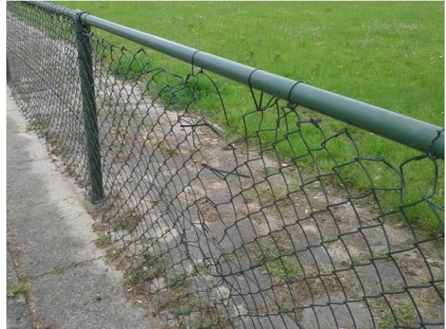
afbeelding 2: gaten en scherpe delen gaashekwerk
