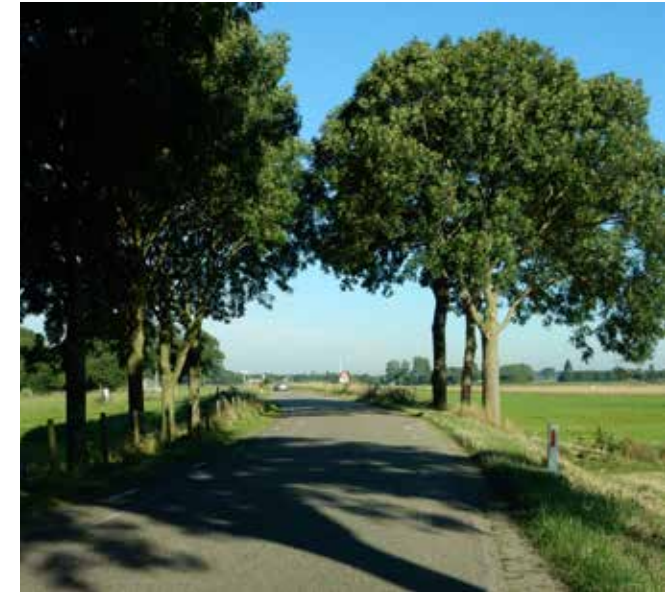
De Essendijk is de meest herkenbare dijk door het hoogteverschil, de bomen en doorzichten op het achterliggende agrarische land
